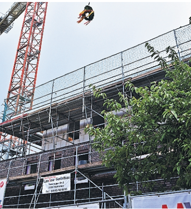
Nun hängt die Richtkrone über dem Rohbau Auedamm. Foto Beneke
